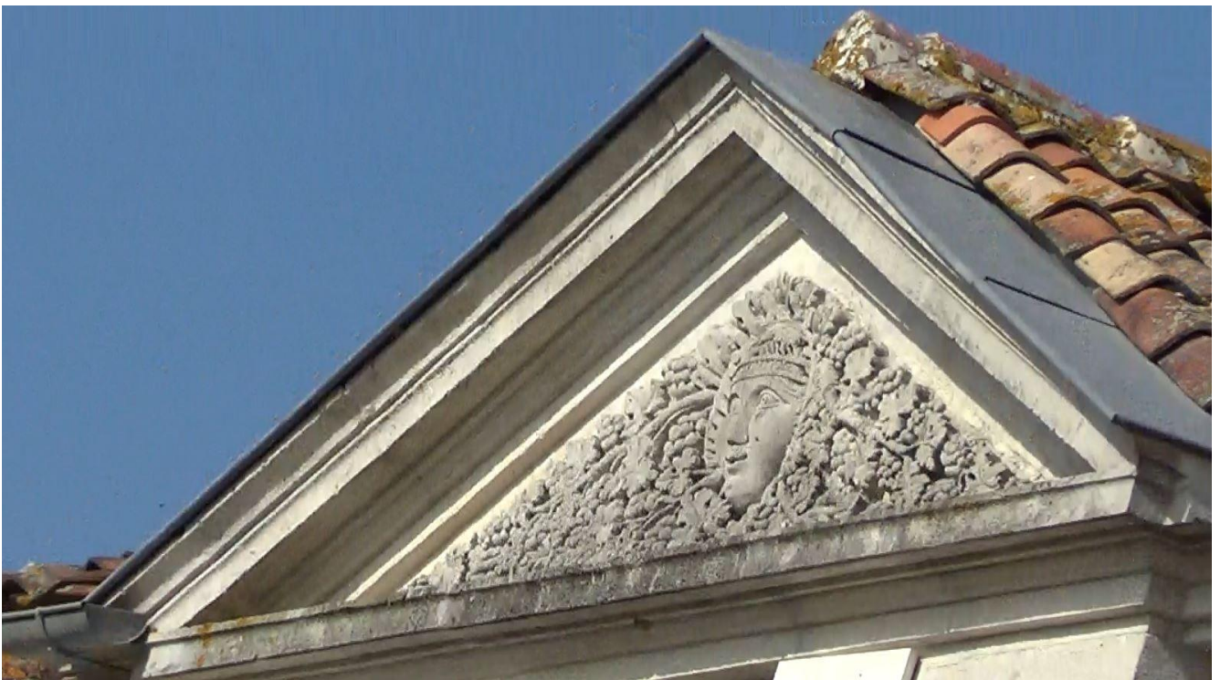
Détail du pignon du 3
