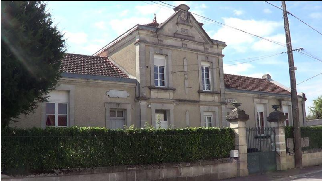
Ecole, 1 rue du vieux Porche
