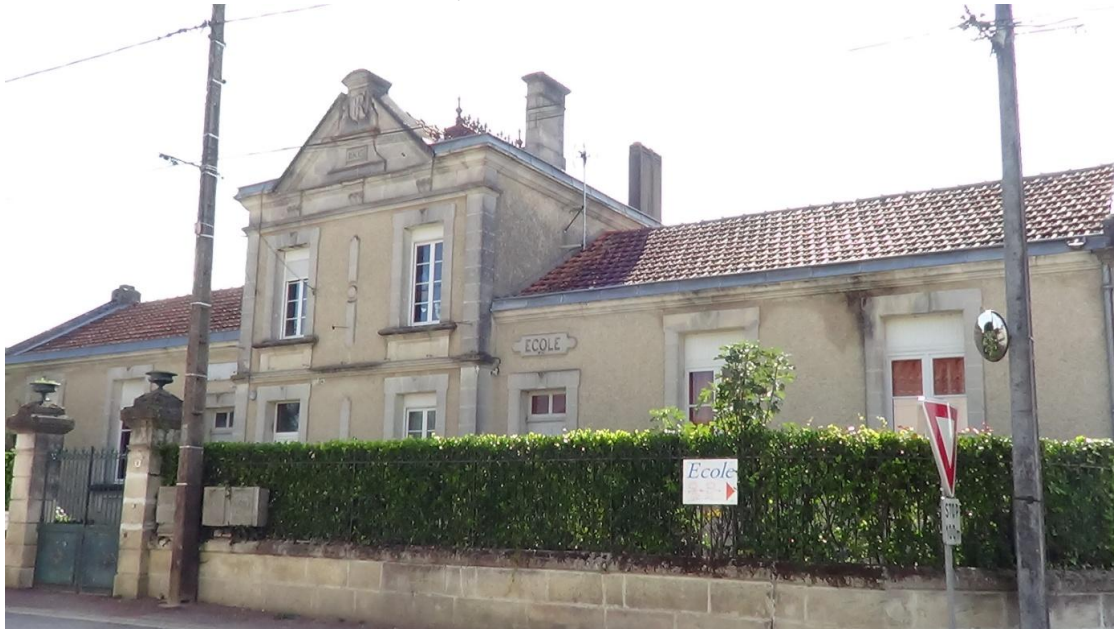
Ecole, 1 rue du vieux Porche
