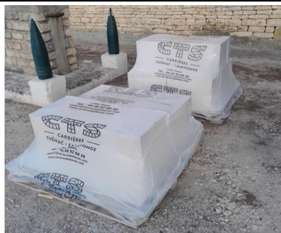
les blocs arrivent vendredi 11
