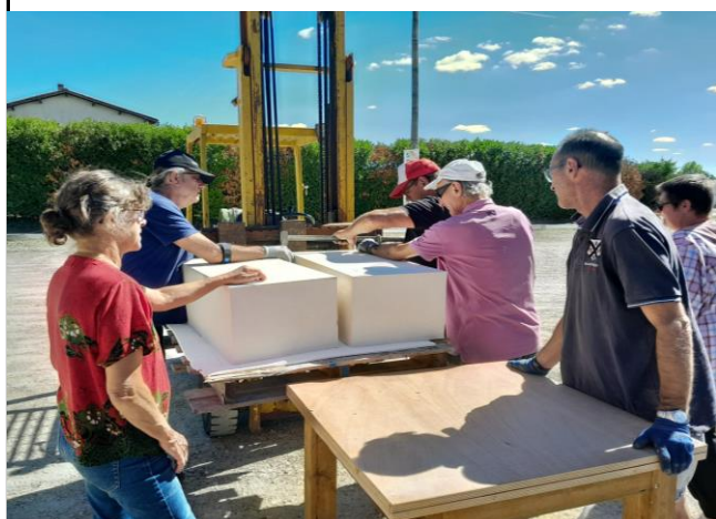
mise en place des blocs
